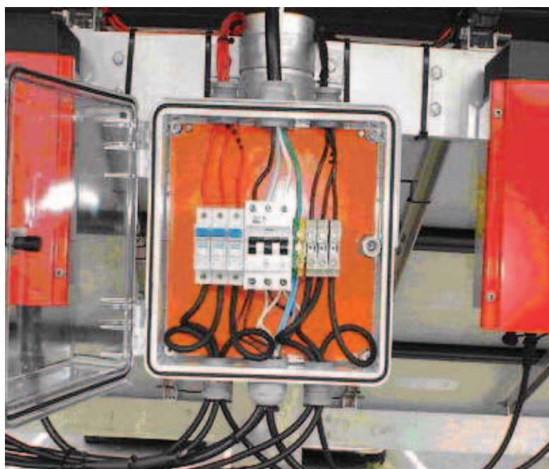
Figura 17. Detalhe da proteção em cc e ca.
