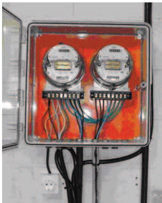
Figura 18. Detalhe da medição.
